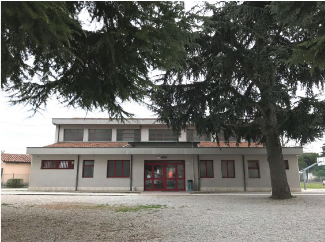
Foto 3: Prospetto nord ovest Palazzina Palestra
